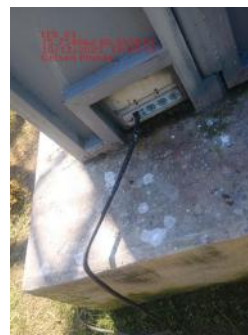
Limpieza o aspirado de filtro de circulacion de aire
