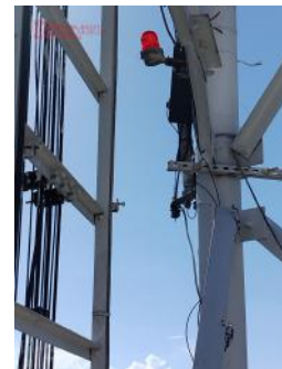
Focos de Baliza inferior/superior
