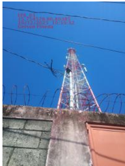
Limpieza de Main AC
