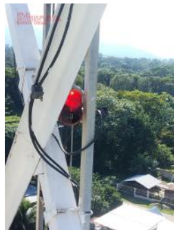
Focos de Baliza inferior/superior
